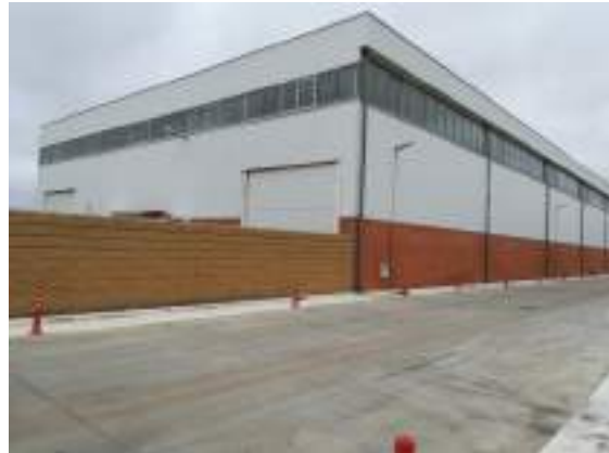
imagen patio y nave 1
