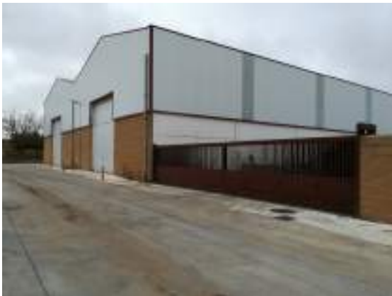
imagen patio y nave 2
